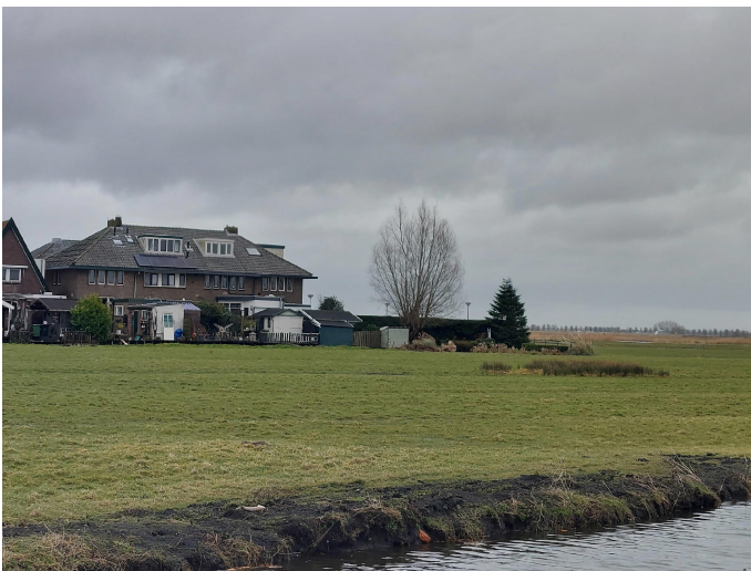
Foto 3-1 Schuurtjes met een asbestverdacht dak
