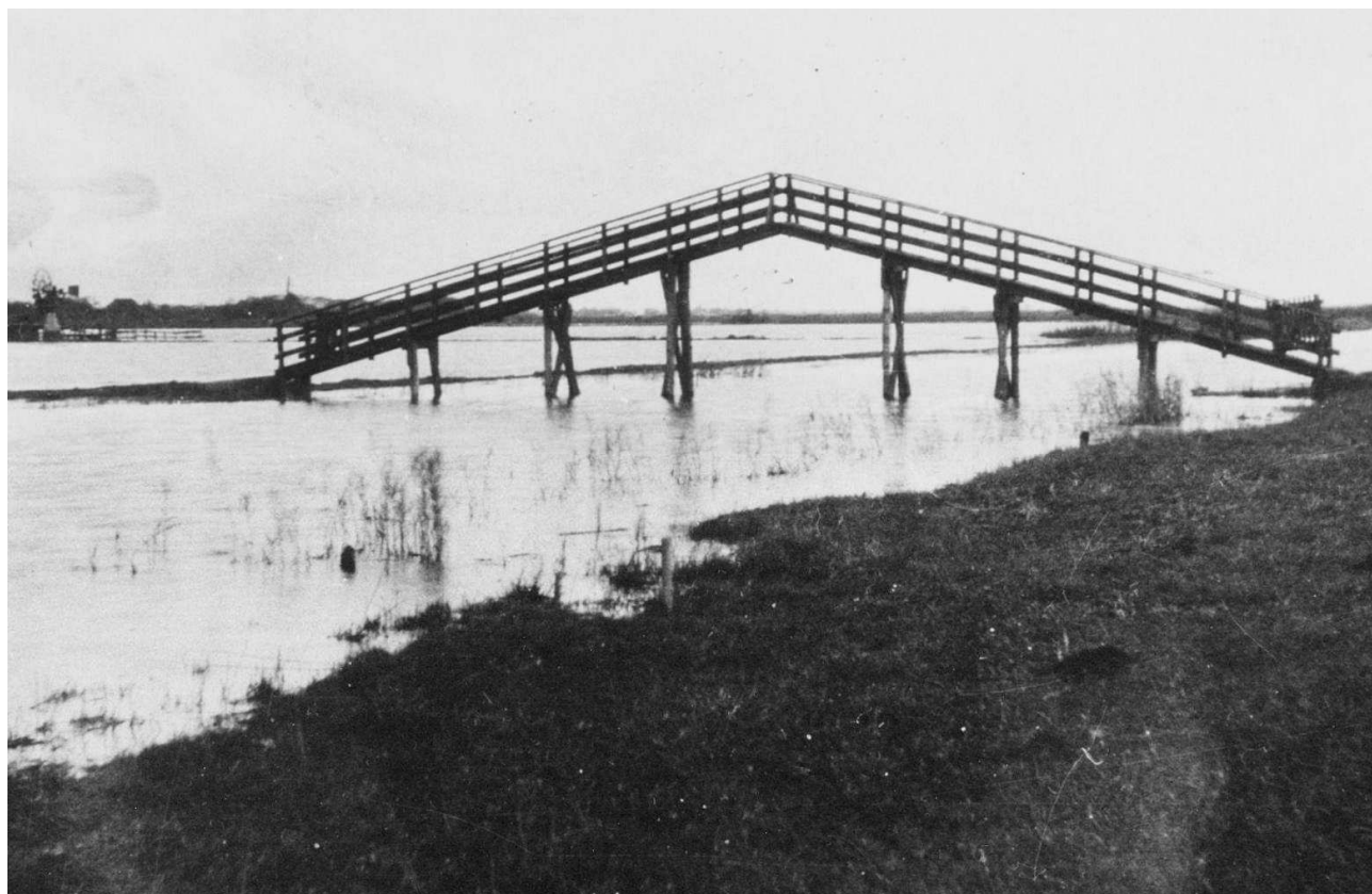
Figuur 37. De houten Kippenbrug van de Enge Wormer naar het Wezenland, omstreeks 1925. Op de voorgrond de oever van de Enge Wormer en de ringvaart. Op de achtergrond het geïnundeerde Wezenland, een situatie die ook nog in 1945 voorkwam (zie de RAF-foto in fig. 36 en 38). De inundatie laat ook goed zien hoe nat de weidevogelgraslanden vroeger waren. Links aan het einde van de brug is nog net molen de Koker te zien. Bron: fotocollectie Jan Vink, Waterlands Archief, coll. nr. WAT002001977.
